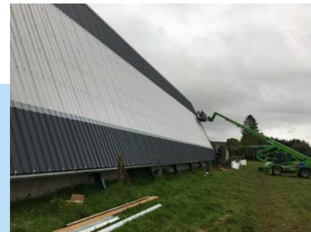
Remplacement de la toiture du gymnase d'Ailly-le-Haut-Clocher
