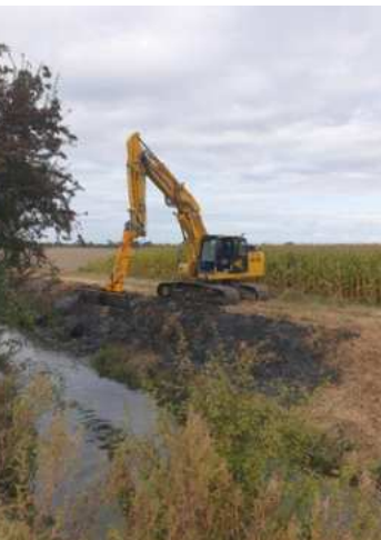
Nouvelle pelle hydraulique livrée fin mai 2024
