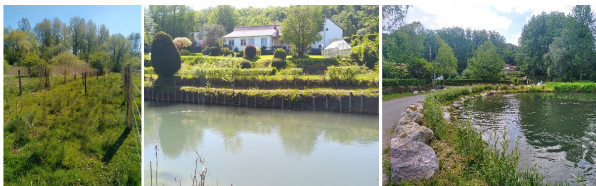
Figure 2 : Plantation d'une haie à Le Bois, Protection de berge en génie végétal à Dompiere-sur-Authie, et protection de berge en technique mixte à Nampont
